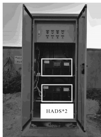
图12 示范工程现场
